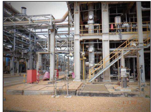
บ่อรวบรวมน้ำฝนปนเปื้อนบริเวณหน่วยผลิต ACH
