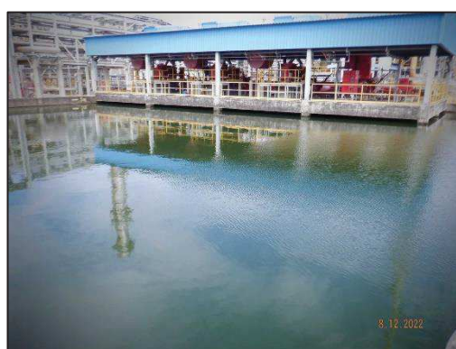
รูปที่ 3-43 บ่อน้ำสำรองดับเพลิง
