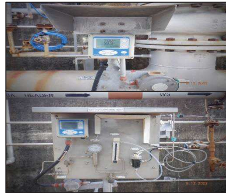
เครื่องตรวจวัด pH และ Conductivity บริเวณบ่อพักน้ำทิ้ง ขนาด 9,600 ลูกบาศก์เมตร
