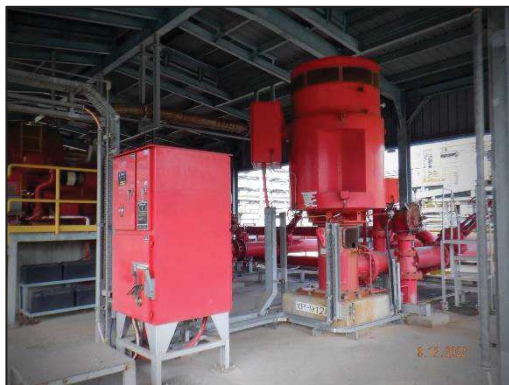
เครื่องสูบน้ำดับเพลิงแบบ Electrical Pump และ Diesel Pump
