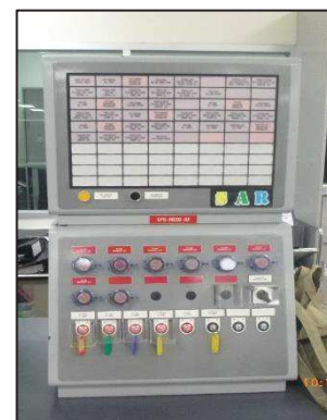
ตัวอย่าง Emergency shutdown system – ESD Control Panel ของ MMA Plant สามารถสั่งหยุดระบบกรณีพบการรั่วไหลได้ในห้องควบคุม
