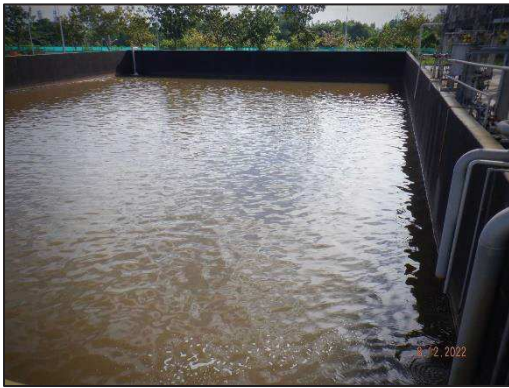
บ่อพักน้ำทิ้งขนาด 9,600 ลูกบาศก์เมตร
