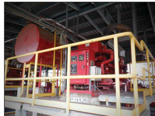
เครื่องสูบน้ำดับเพลิงแบบ Electrical Pump และ Diesel Pump
