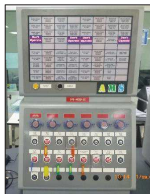
ตัวอย่าง Emergency shutdown system – ESD Control Panel ของ MMA Plant สามารถสั่งหยุดระบบกรณีพบการรั่วไหลได้ในห้องควบคุม
